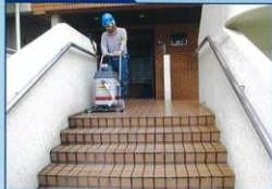
汚れを洗浄剤で除去する「下地処理」。
